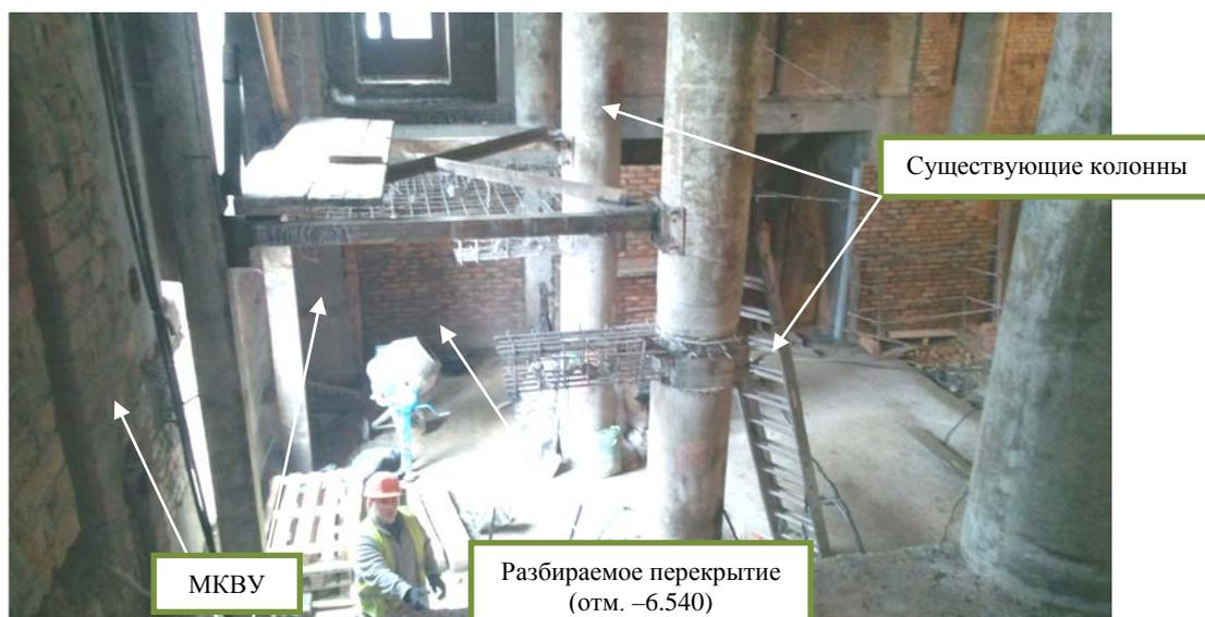
Рис. 4. Устройство металлической конструкции временного усиления перекрытия
