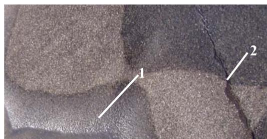
Рис. 5. Дефекты, вызванные нарушениями технологии выполнения кровельных работ: 1 – вздутия между слоями кровельного рулонного ковра; 2 – отслоения в местах нахлестки полотнищ
