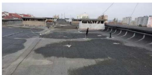
Рис. 4. Застой атмосферной воды на кровле
