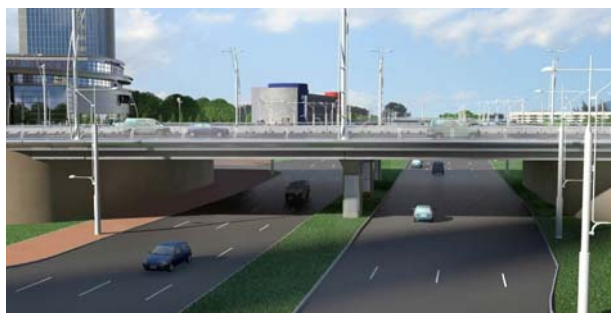
Рис. 1. Общий вид транспортной развязки по проспекту Независимости над эксплуатируемыми тоннелями метрополитена
