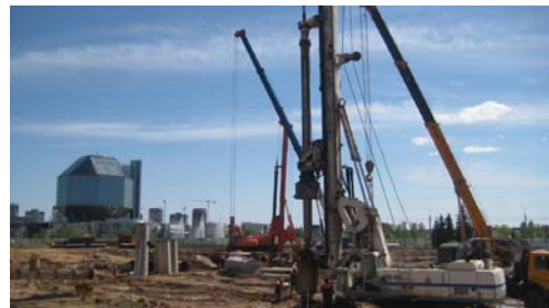
Рис. 3. Работы по устройству буронабивных свай защитного экрана гидравлической бурильной машиной SF-65 фирмы SOILMEC
