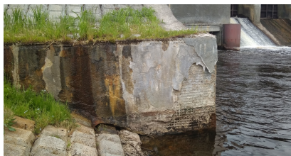
Рис. 4. Низовой открылок правобережного устоя Клястицкой ГЭС
