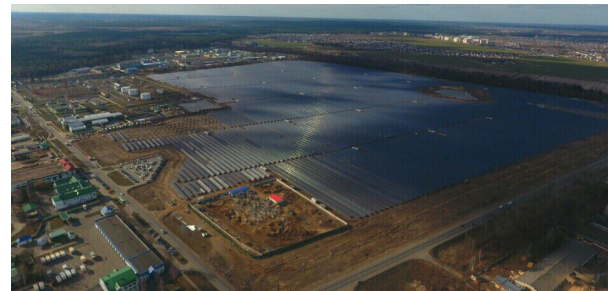
Рис. 4. Фотоэлектростанция в Речицком районе
