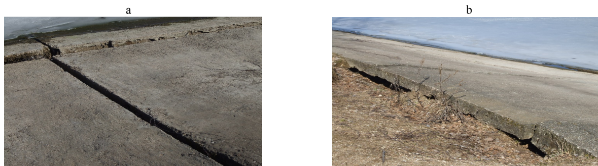
Рис. 3. Повреждение железобетонного крепления откосов: а – осадочные швы; б – температурные швы
