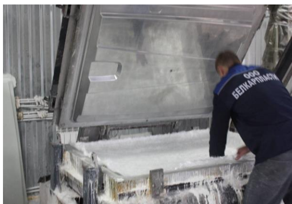
Рис. 5. Укладка армирующего слоя (заготовки из стекломата)
