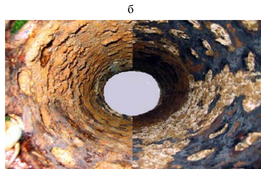
Рис. 3. Фрагмент: а – внешней части фильтра до и после проведения декольматации; б – внутренней
