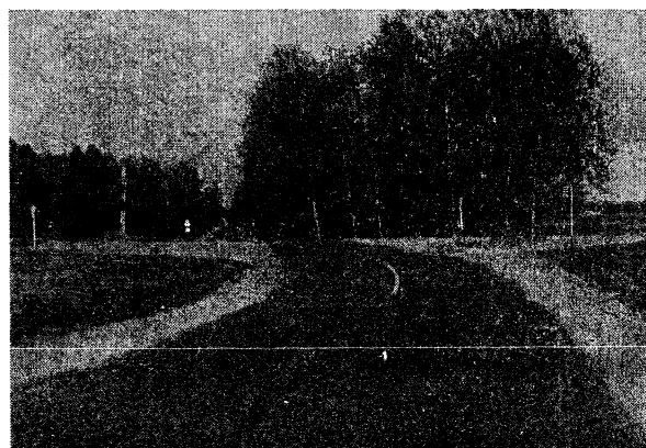
Рис. 3. План трассы капитального ремонта автомобильной дороги предусматривает вписать в угол поворота радиус кривой 2000 м, а фактически оставлен план трассы существующей дороги, имеющей S-образную кривую с радиусами по 60 м
