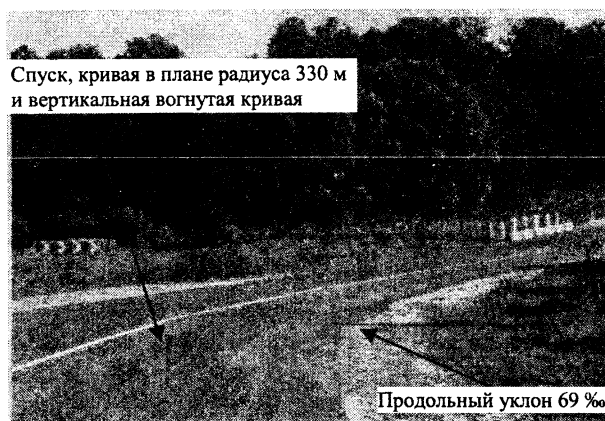
Рис. 4. Вид закругления радиуса 330 м на дороге в месте ДТП, а в техническом паспорте дороги указан радиус 1056 м, продольный уклон фактически равен 69 ‰, а в техническом паспорте указан 4 ‰
