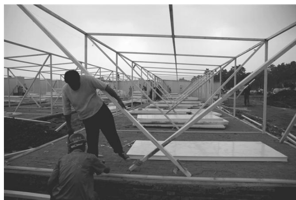
Рис. 3. Монтаж каркаса временного сборного здания
