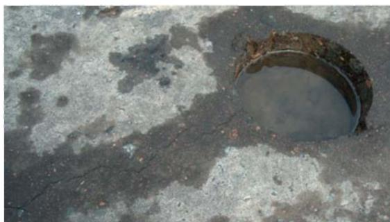
Рис. 3. Заполнение керна водой в местах развития коррозионных деформаций
