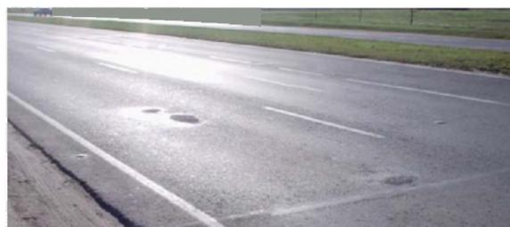
*Рис. 2.* Разрушение покрытия за счет появления белых пятен
